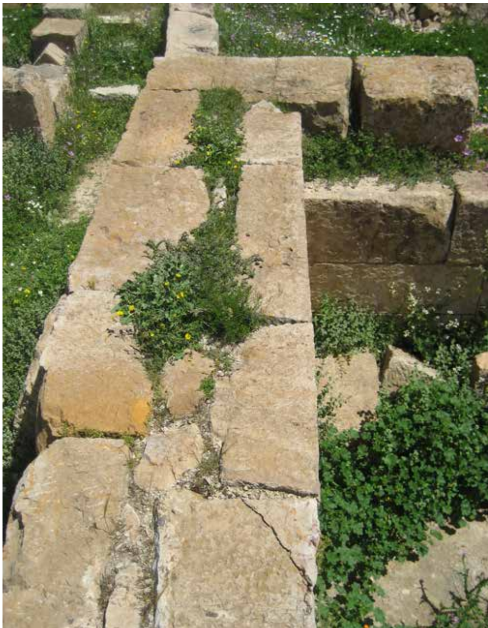
Fig. 10 : Tébéssa Khalia. Bâtiment à l'entrée du site (Cliché R. Hanoune).
