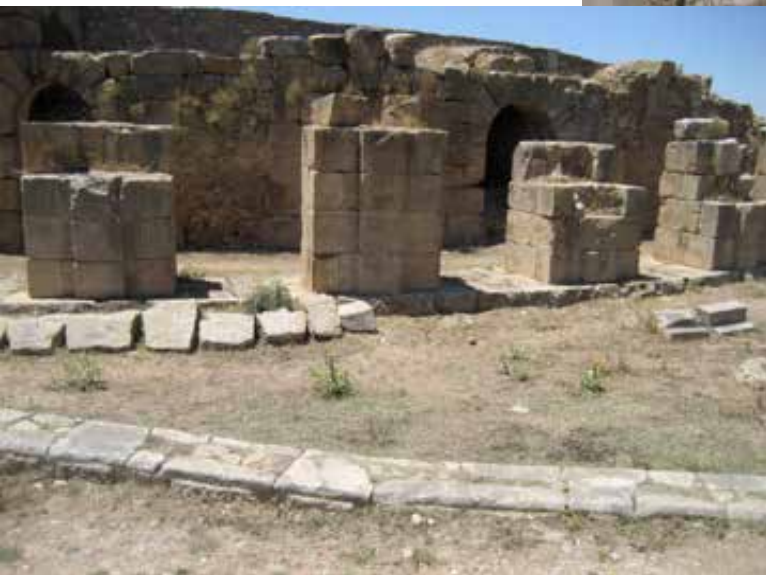
Fig. 4b : Bulla Regia. Théâtre, espace au nord-est, mur arasé (Cliché R. Hanoune).
